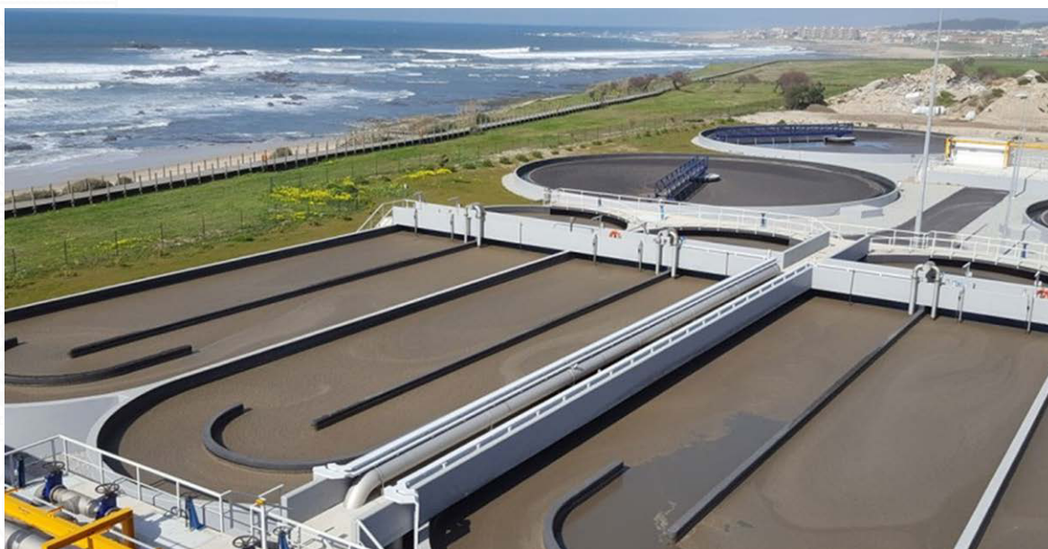
Figura 8.5. PTAR operando con Canales de Oxidación (Matosinhos, Portugal).
