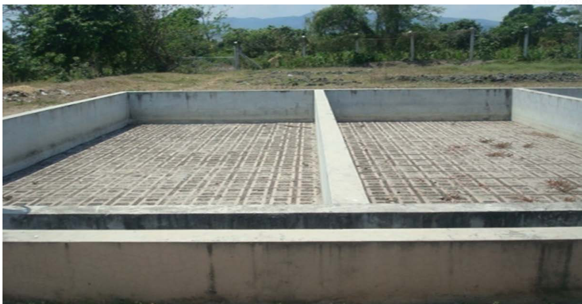
Figura 11.18. Lechos de Secado de lodos con capa de ladrillos en la parte superior. PTAR de San Juan de Opico (El Salvador).
