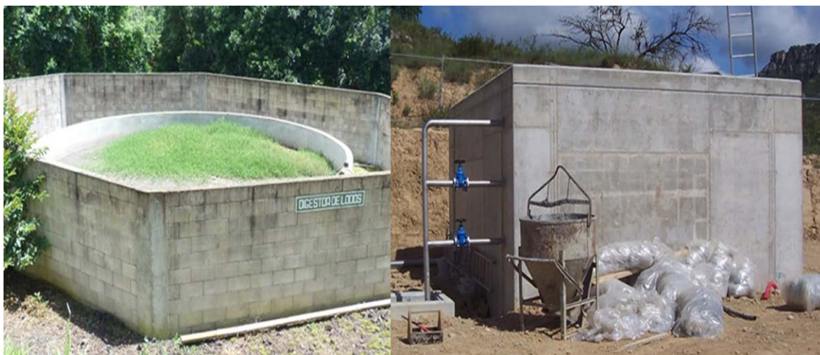
Figura 11.5. Izquierda: digestor de lodos a temperatura ambiente, cilíndrico y sin cubrir (Apaneca, El Salvador). Derecha: digestor de lodos a temperatura ambiente rectangular y cubierto (Prejano, España).
