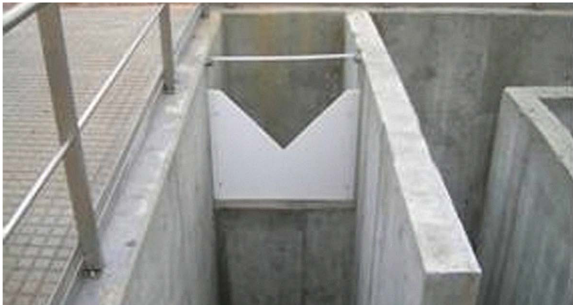
Figura 6.27. Instalación de un vertedero triangular (MARM, 2010).
