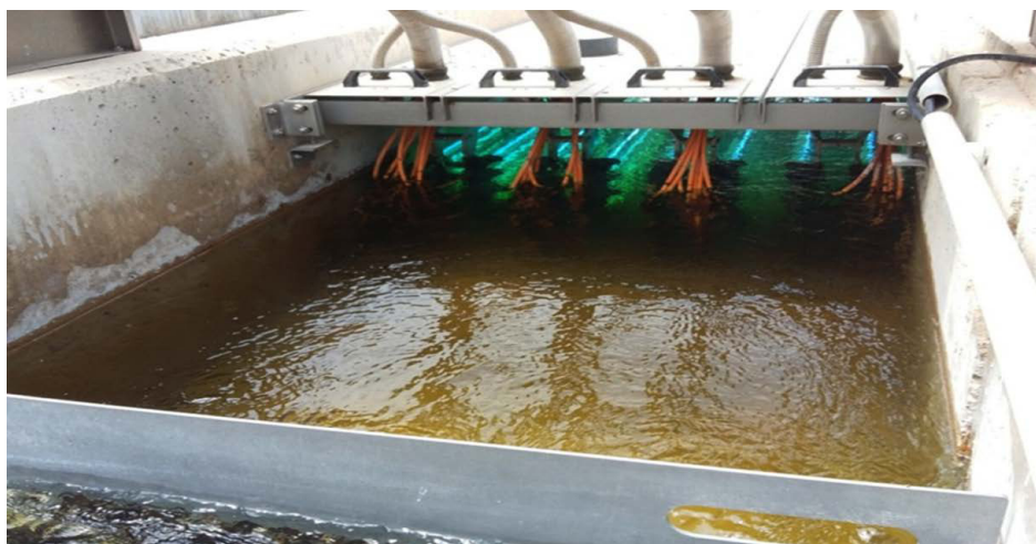
Figura 5.13. Aplicación de Radiación UV para la desinfección de las aguas (PTAR de los Alcázares, España).
