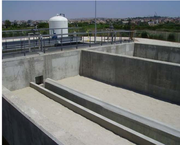
Figura 10.9. Esquema y filtro de arena por gravedad.
