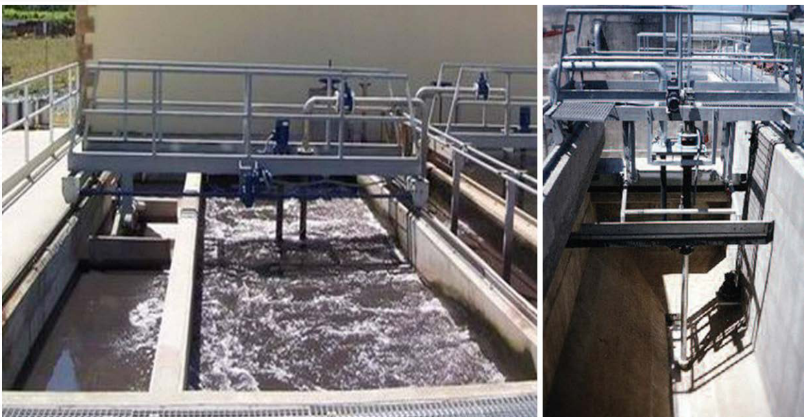
Figura 6.24. Desarenadores-desengrasadores aireados.
