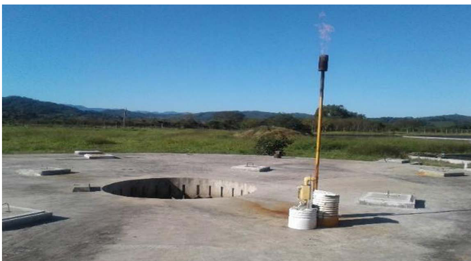
Figura 5.5. Reactor Anaerobio de Lecho Fluidizado (RALF) (PTAR de Monteagudo, Bolivia).
