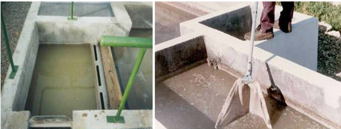
Figura 6.22. Extracción de las grasas mediante tuberías acanaladas y recogedor de grasas.
