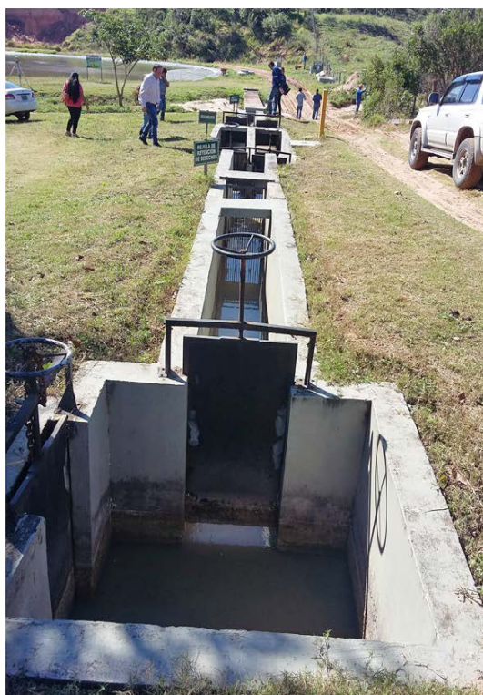
Figura 5.1. Pretratamiento de la PTAR de La Guardia (Bolivia).
