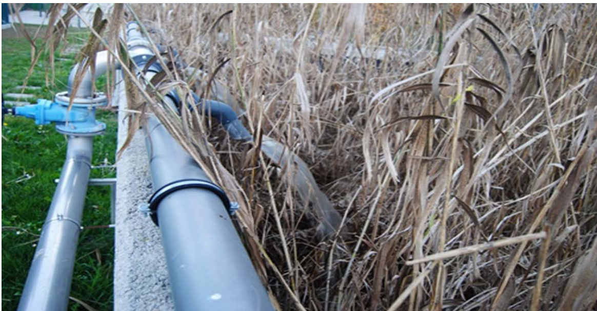
Figura 11.23. Alimentación de un humedal para lodos. EDAR de Santa Eulalia de Ruiprimer (España).
