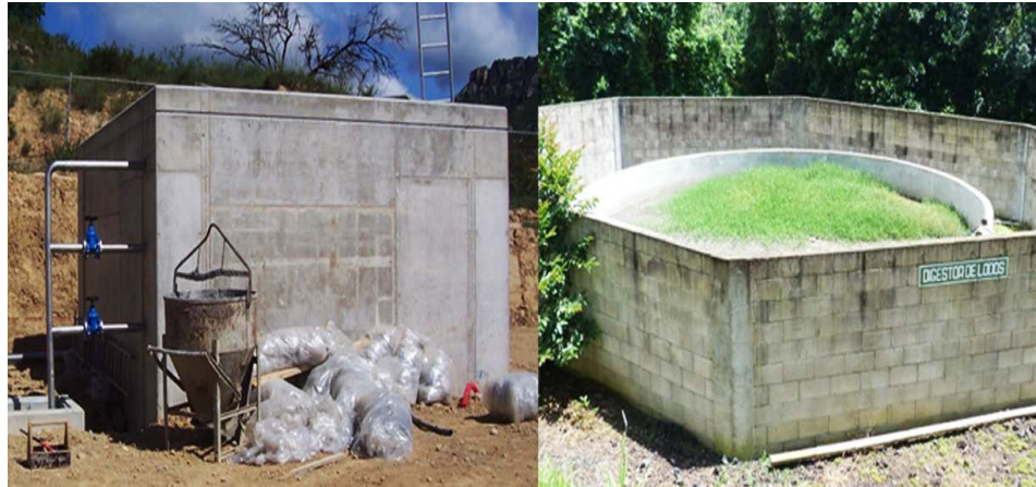
Figura 5.15. Digestores Anaerobios de lodos a temperatura ambiente (a la izquierda digestor en Prejano, La Rioja, España, y a la derecha digestor en Apaneca, El Salvador).
