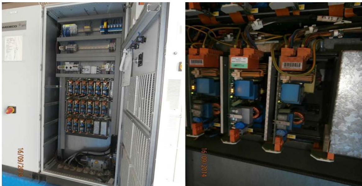
Figura 9.10. Cuadro eléctrico con balastros.
