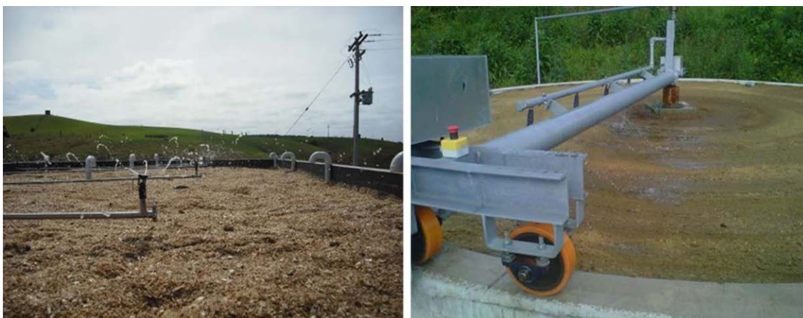
Figura 7.102. Riego de Lombrifiltros mediante aspersores y mediante un brazo de distribución giratorio (BIDATEK).
