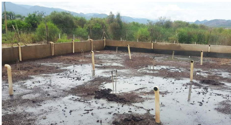
Figura 5.8. Lombrifiltro (PTAR de Saipina, Bolivia).
