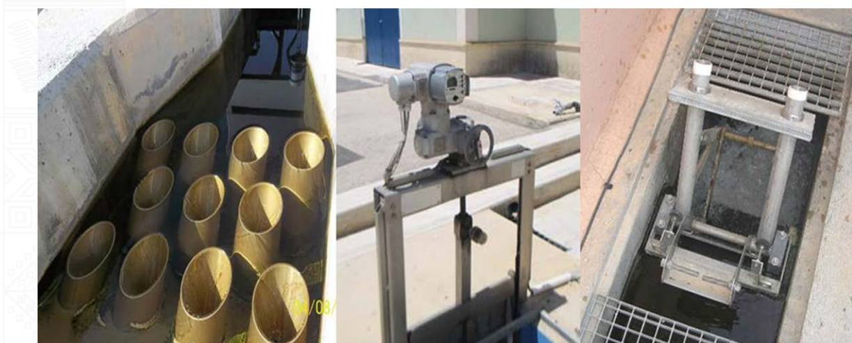
Figura 9.13. Vertedero tubular fijo y vertederos móviles de compuerta y de bisagra con contrapesos.
