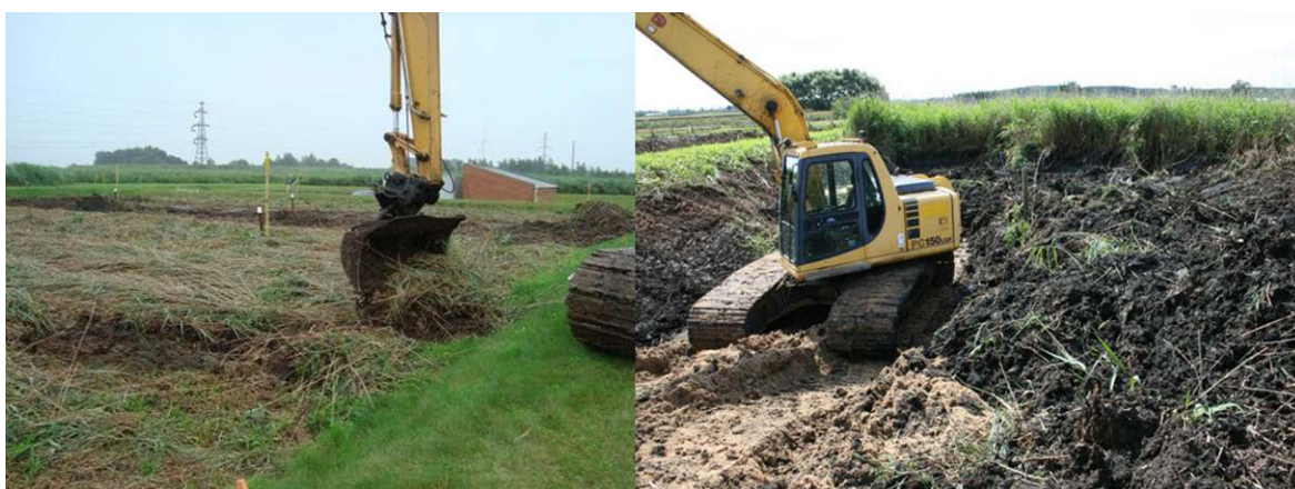
Figura 11.24. Extracción de los lodos deshidratados y de la parte aérea de la vegetación en un Humedal Artificial para el secado de lodos, en la PTAR de Greve (Dinamarca), que da servicio a 50.000 habitantes (Uggetti, 2010).
