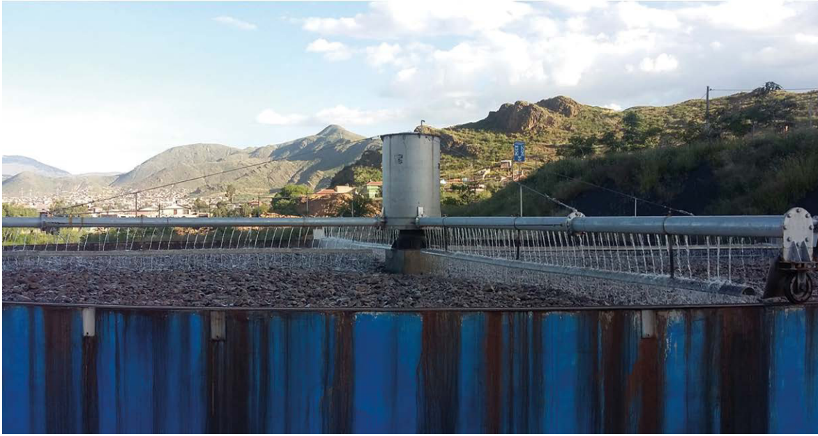
Figura 7.146. Filtro Percolador con sistema de distribución móvil por carga hidráulica (PTAR El Abra, Sacaba, Bolivia).
