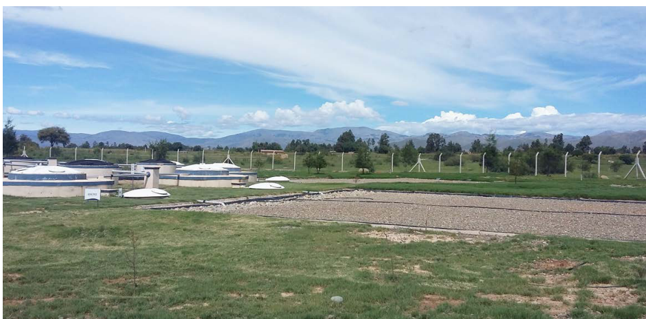
Figura 5.7. Humedales Artificiales tras RAFA (PTAR de Cliza, Bolivia).
