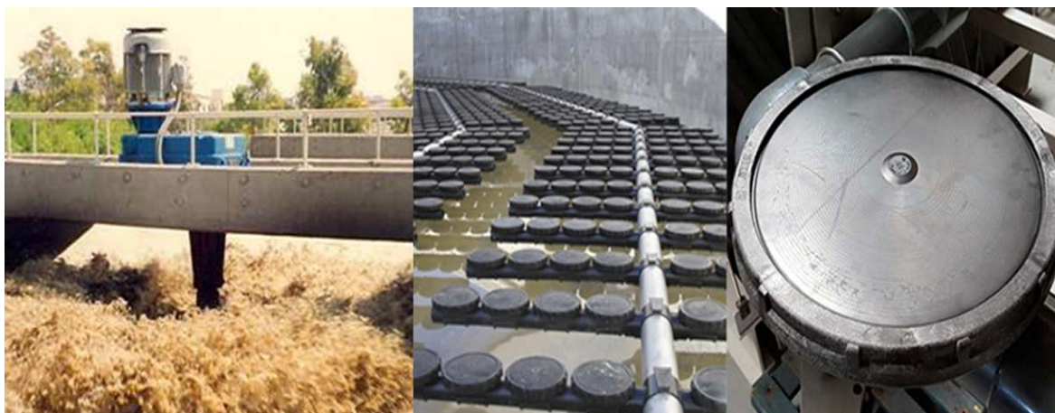
Figura 7.181. Aireación mecánica y mediante difusores.
