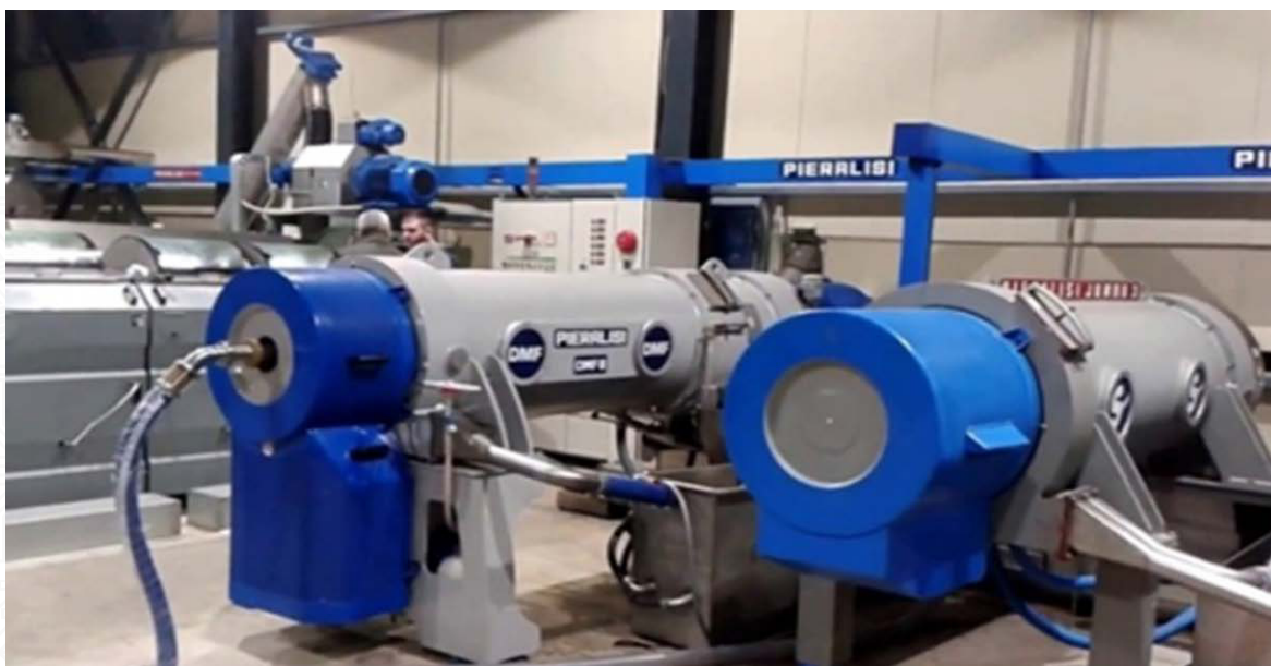
Figura 11.11. Centrifugas para la deshidratación de lodos.
