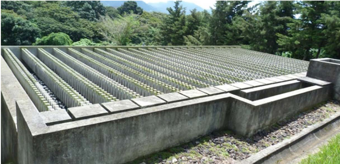
Figura 7.145. Filtro Percolador con sistema de reparto fijo.
