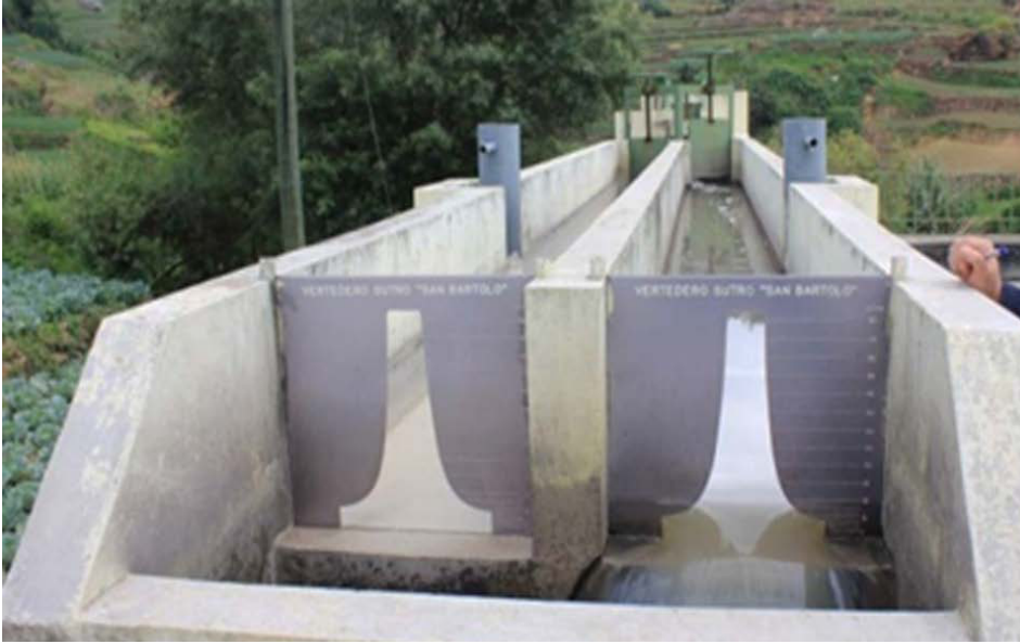
Figura 6.16. Vertederos Sutro en canales desarenadores de flujo constante (del Río, 2018).
