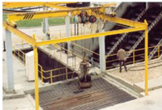
Figura 6.1. Esquema de un pozo de gruesos y construcción de uno de ellos a la entrada de una PTAR (en primer plano la cuchara bivalva para la extracción de los residuos) ( Ortega, 2015 ).
