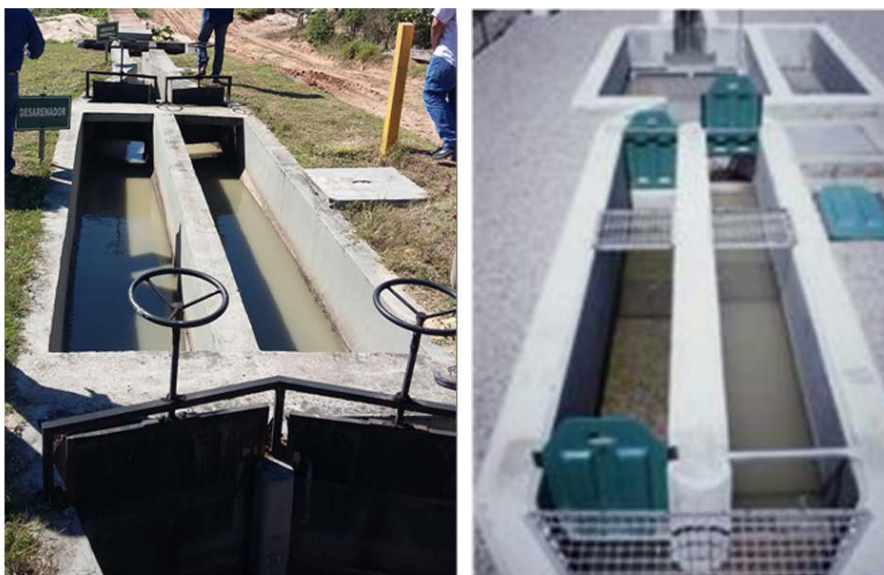
Figura 6.14. Canales desarenadores de flujo variable.
