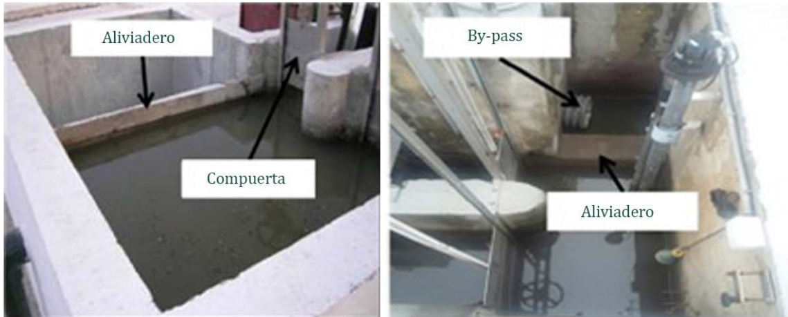
Figura 6.2. Elementos de la obra de llegada en una PTAR.
