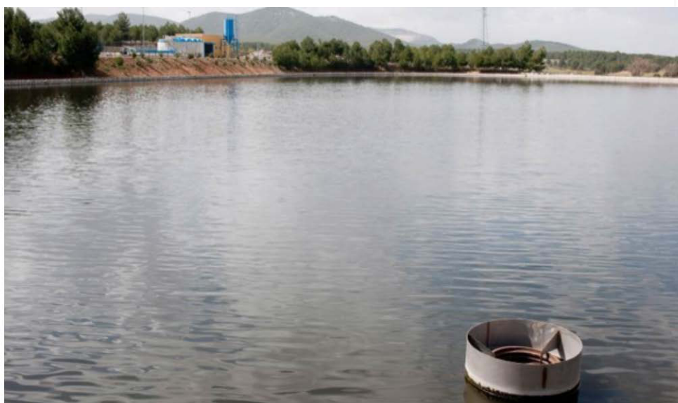
Figura 9.15. Laguna de Maduración para la desinfección de aguas tratadas (Abellán, 2018).
