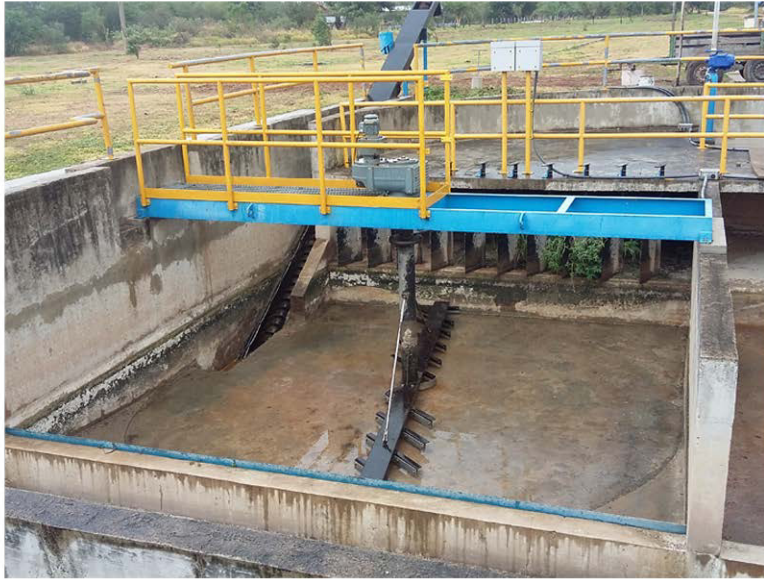
Figura 6.18. Desarenador cuadrado de flujo horizontal.
