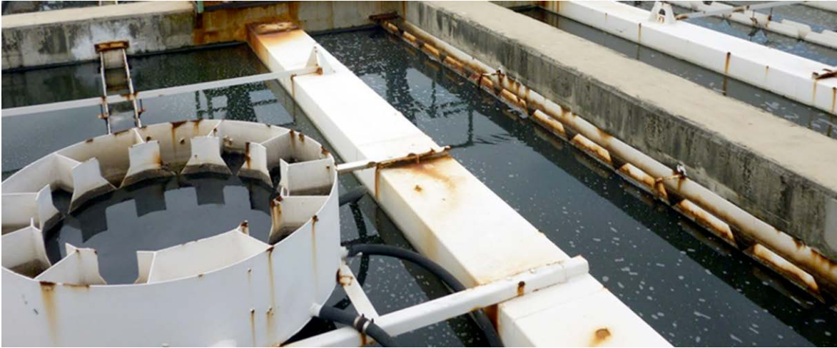
Figura 7.40. Aspecto de un RAFA a los siete años de operación por una mala selección de la calidad de los materiales constructivos (Wagner, 2018).
