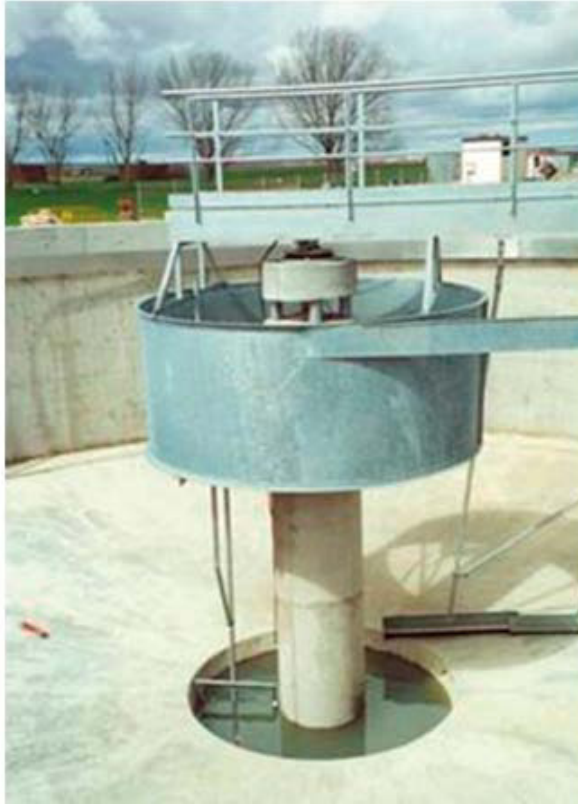
Figura 7.148. Detalle de la entrada a un sedimentador secundario.
